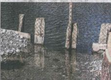
Pieux et planches maintiennent le gravier. Il y a des entrées d'eau pour permettre aux poissons de venir frayer. Photo L'Alsace
